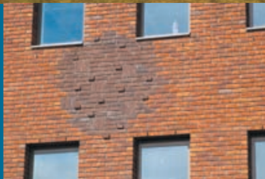
Gemetselde vlek is opgebouwd uit andere kleurenmix en uitstekende stenen
